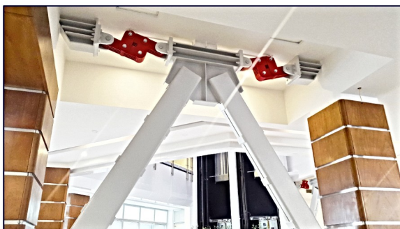
ساختمان مرکزی بانک گردشگری
